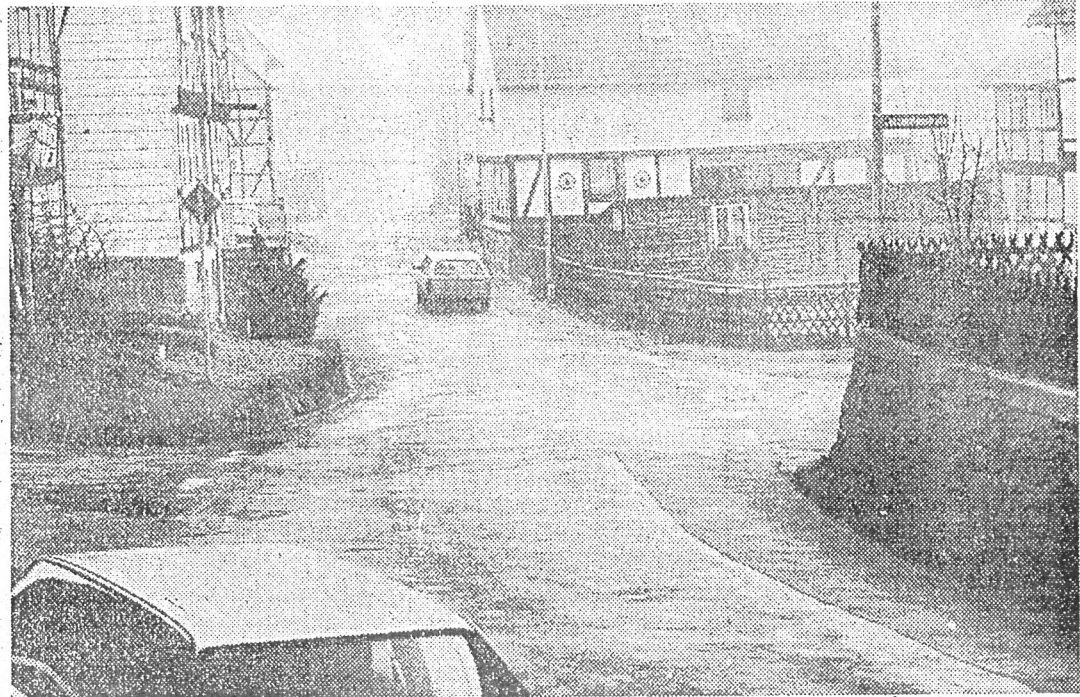
VOR DIESER STÜTZMAUER (rechts) soll der Fußweg bis zur Einmündung in die Sensensteinstraße geführt werden. Eine leichte Verschwenkung der Straße ist deshalb erforderlich. (Foto: Jelinek)
