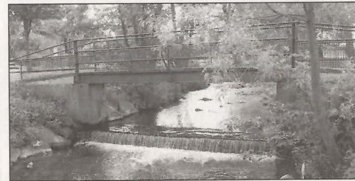
Vorher: Solche Abstürze behinderten Fische und Kleinstlebewesen. FOTO: BÜRO WAGU/NH
