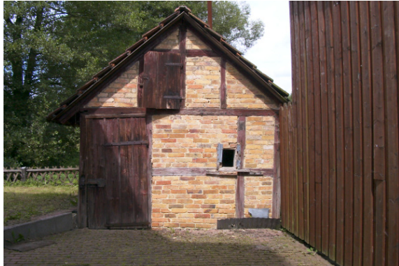
Alter „Schuppen“ der Freiwilligen Feuerwehr soll weichen ... (Archiv-Foto aus 2002)
