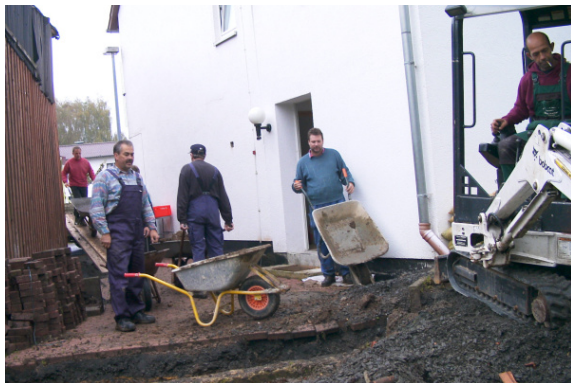
02. Oktober 2004: In Eigenarbeit wird durch Kameraden der Feuerwehr der Erdaushub durchgeführt.
