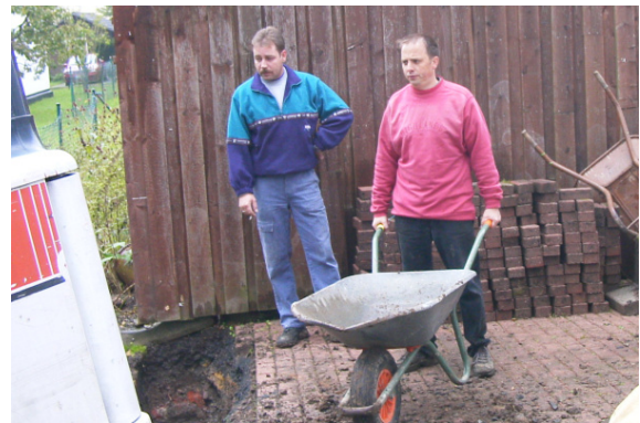
Volker Kullmann wartet auf die nächste Baggerschaufel voll „saftigem“ Erdreich.
