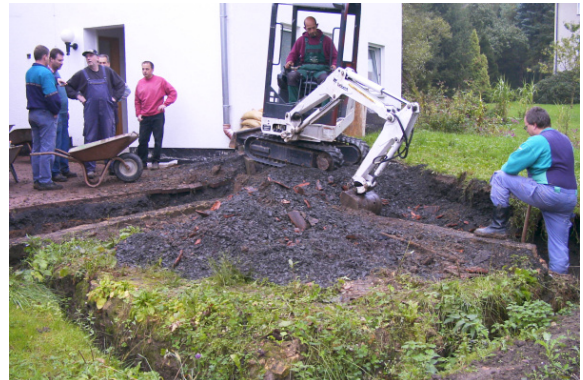
Baggern – baggern und ...
