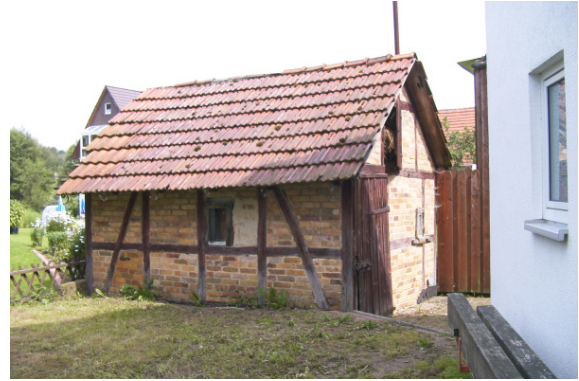
... und durch eine neue Blockhütte ersetzt werden. (Archiv-Foto aus 2002)
