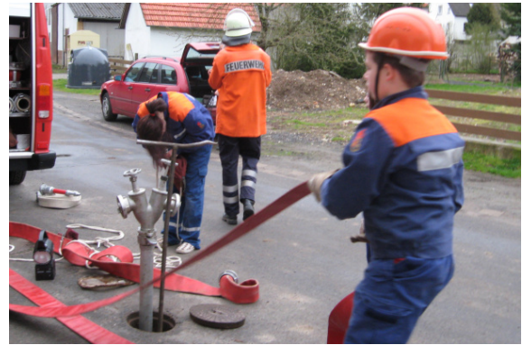
Abbau der Wasserversorgung.
