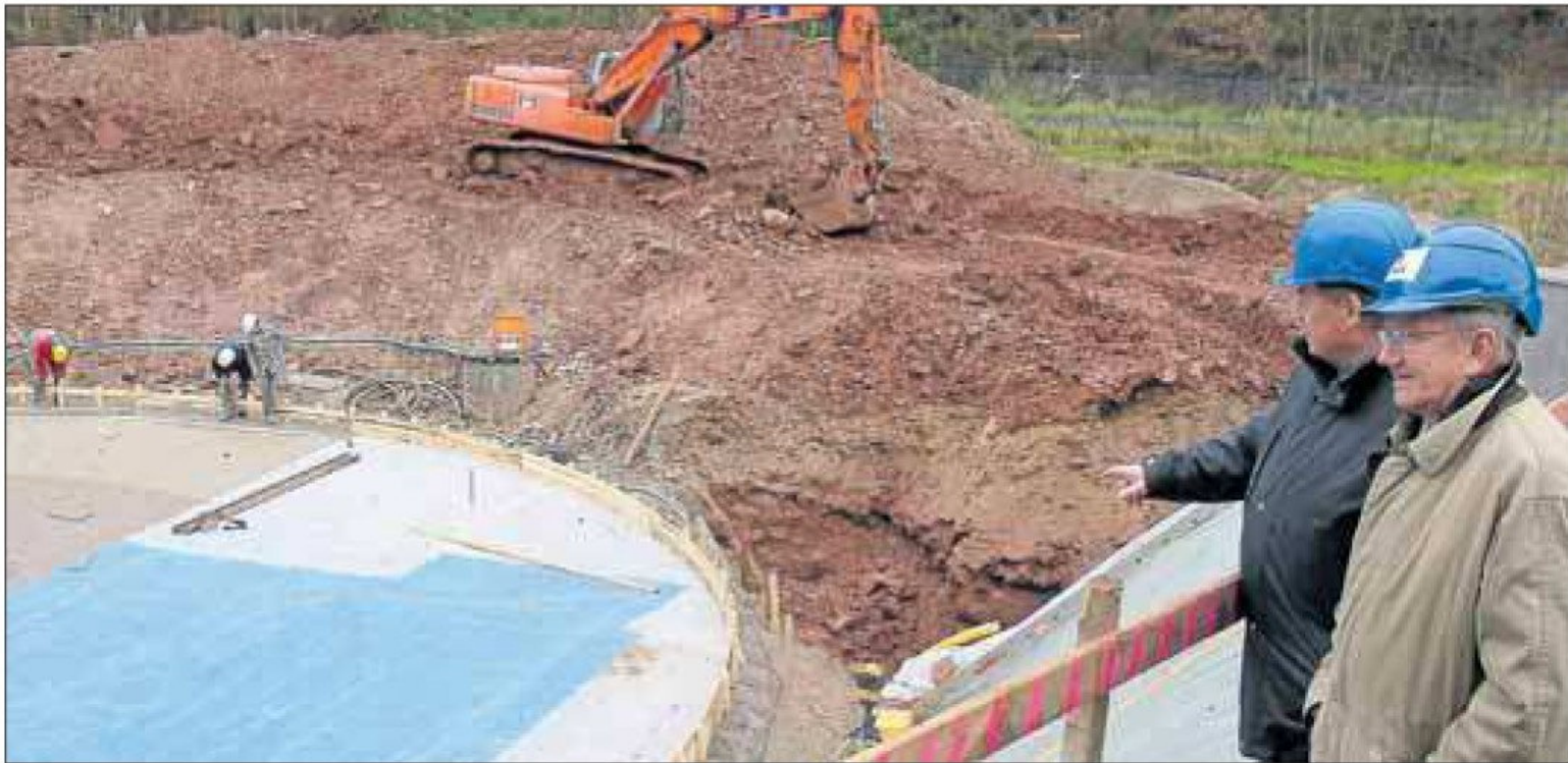
Neues Klärbecken: Henning Schaare, Technischer Leiter des Wasserverbandes Peine, erläutert Staufenbergs Bürgermeister Volker Zimmermann (vorne) den Stand der Bauarbeiten an der Kläranlage in Uschlag
