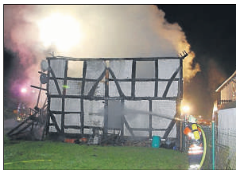
Das Feuer hatte zunächst die Scheune im hinteren Teil des Gebäudes vernichtet.
