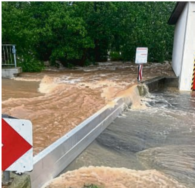
Im Ortskern von Dahlheim schwappte die Flutwelle über einen mobilen Damm. FOTO: FEUERWEHR STAUFENBERG/NH
