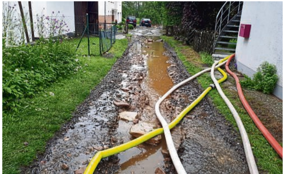
Der Wiesenweg während der Flut: Der Schotterweg wurde von den Wassermassen aufgerissen. FOTO: EKKEHARD MAASS
