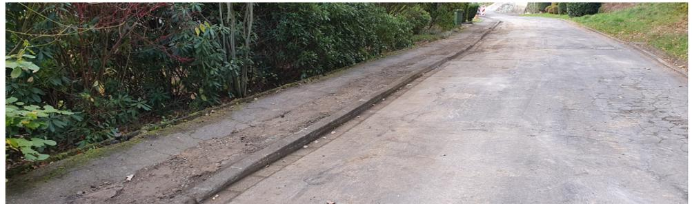
**Glasfaserausbau (4).** Die Arbeitsschritte laufen Hand in Hand. Trassenverlauf öffnen – Glasfaser verlegen – und provisorisch wieder verschließen. Bisher scheint in Dahlheim alles reibungslos verlaufen zu sein. Die Arbeiten im Drosselweg müssten vorläufig abgeschlossen sein. Im Amselweg ist die Hälfte der Strecke auch schon geschafft. (Foto: Volker Kullmann)
